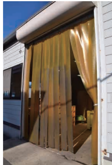
施設の改善 ビニールカーテンによる仕切りでホコリ、チリなどの侵入を防止
