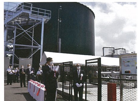
野菜残渣利用し発電(バイオガスエネルギーとわだ)
